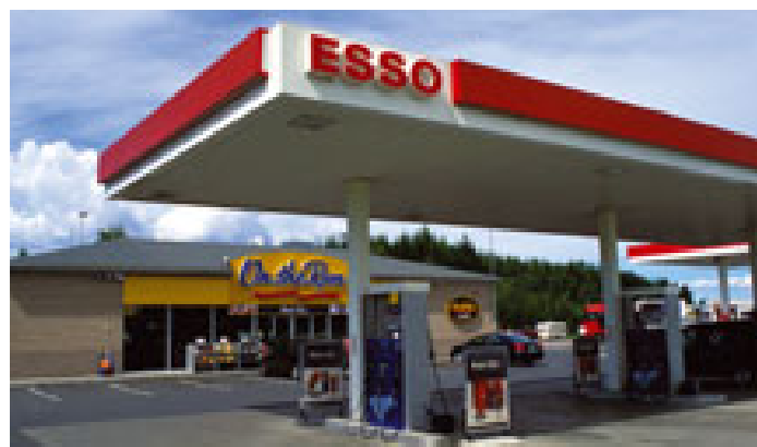
Pr. i dag forsynes 120 Esso-bensinstasjoner på Østlandet med Autodiesel B5 (inntil 5 volumprosent innblandet biodiesel). Bilde: On-the-Run stasjon.
